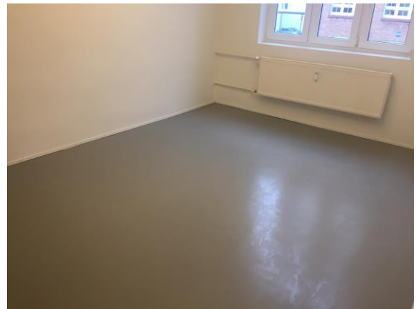
Objekt – Berlin Bouchestraße – 800 m 2 Büro und Studioflächen mit 1a Bodenausgleich 30F und 1a PU Flurversiegelung erstellt
